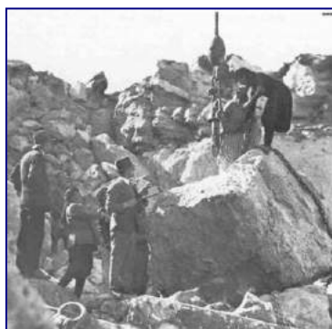
איור 31 עבודות חציבה (ככל הנראה לצרכי בניית הנמל).
