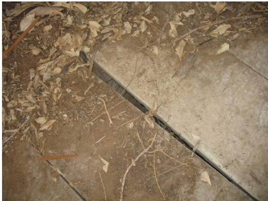
תמונה 4.2-מקלט גן ב'-חיפוי לוחות בטון למדרגות הכניסה למקלט-קיר חדר המדרגות-2007
