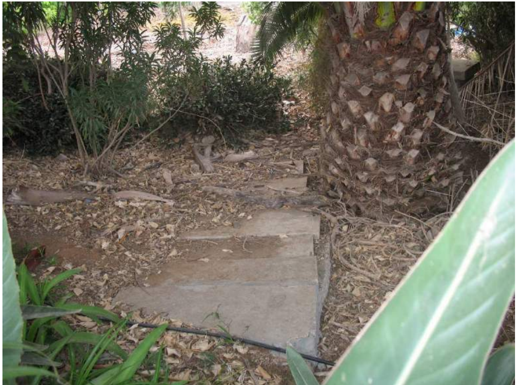
תמונה 4.1-מקלט גן ב'-חיפוי לוחות בטון למדרגות הכניסה למקלט-2007
